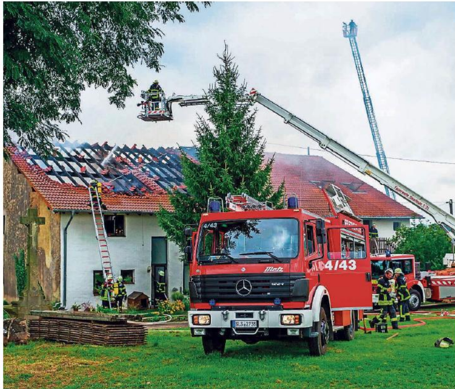
Das Feuer war nach einer Stunde gelöscht, trotzdem ist das Haus nun unbewohnbar.
